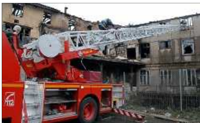
Les sapeurs-pompiers ont déployé la grande échelle et déversé une bonne quantité d'eau.
